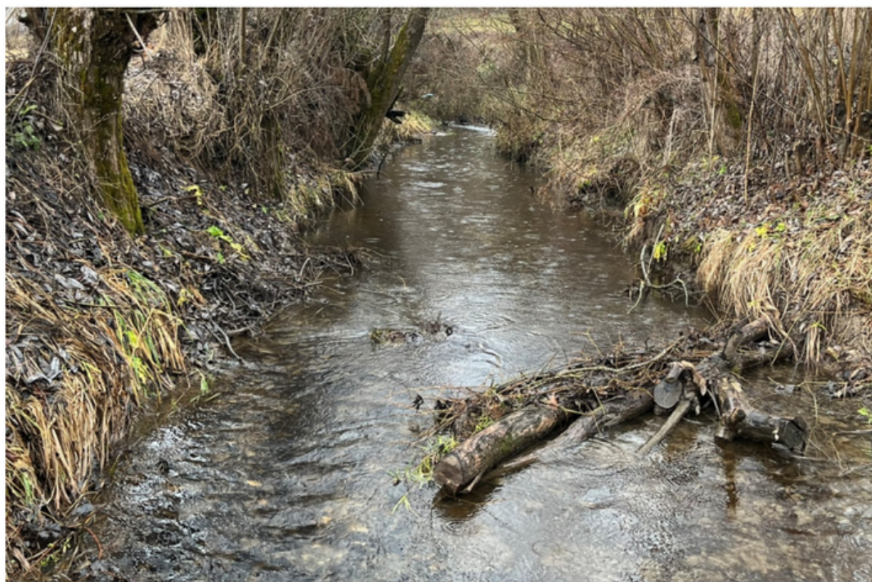
Fot. 4. Koryto potoku
